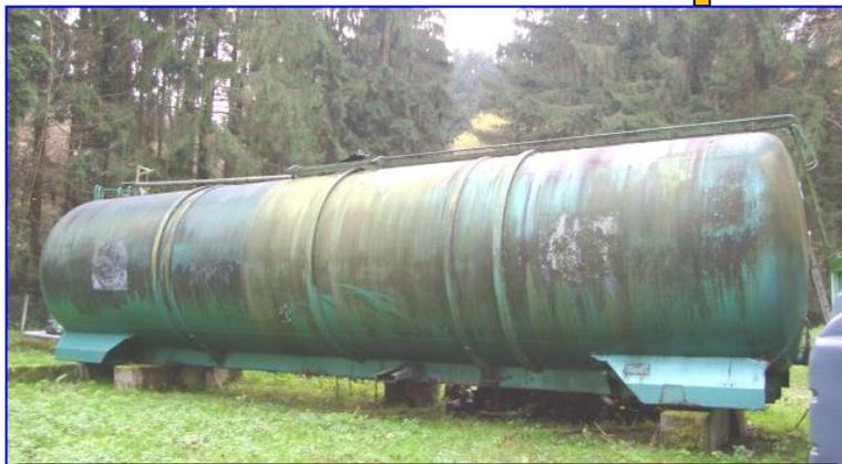
Une citerne de réserve de boues de l'ancienne station d'épuration d'une capacité de 80 m3
