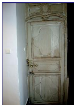
Remise en valeur d'une porte avec moulures
