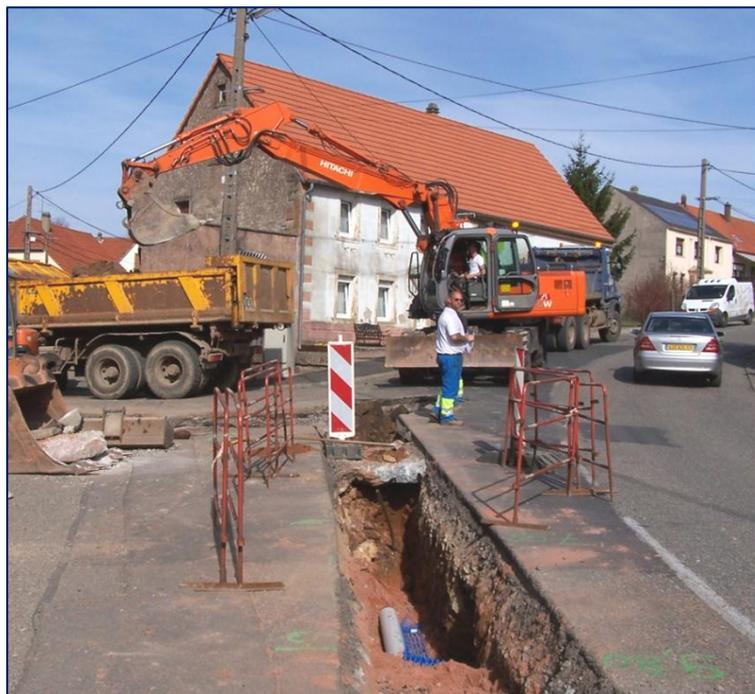
Il a fallu ouvrir des tranchées sur une partie de la chaussée pour remplacer l'ancienne conduite en fonte de diamètre 150 par une nouvelle de diamètre 160. Les riverains avaient la possibilité à leurs frais de faire réaliser ou non les travaux de remplacement de leur conduite entre le coffret installé en limite de propriété et le compteur actuel. La circulation alternée avec feu tricolore s'imposait d'office pour sécuriser au maximum le chantier et les usagers.
